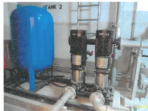
ปั้มน้ำใช้อุปโภค-บริโภค ชั้นดาดฟ้า
