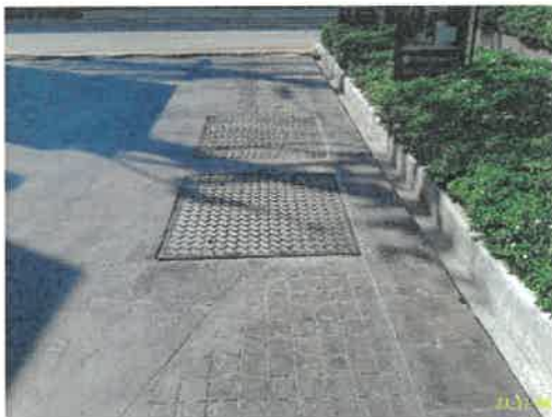
ตะแกรงบ่อสุดท้ายก่อนปล่อยน้ำออกนอกโครงการ
