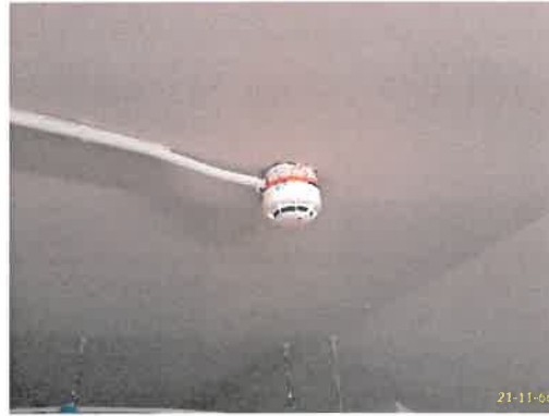
อุปกรณ์ตรวจจับควัน ระบบแจ้งเหตุเพลิงไหม้ (ต่อ)
